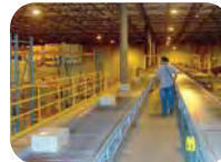
ตรวจความผิดปกติของสายพานลำเลียง
