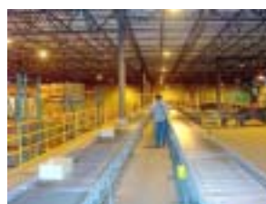
ตรวจความผิดปกติของ สายพานลำเลียง
