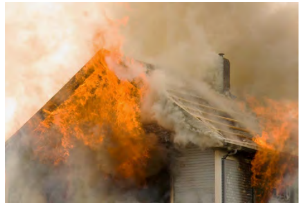
อุบัติเหตุร้ายแรงจากการติดตั้งระบบเซลล์แสงอาทิตย์ไม่ถูกต้อง
