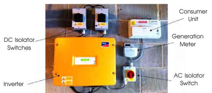
ระบบควบคุมของชุดผลิตกระแสไฟฟ้าจากเซลล์แสงอาทิตย์
