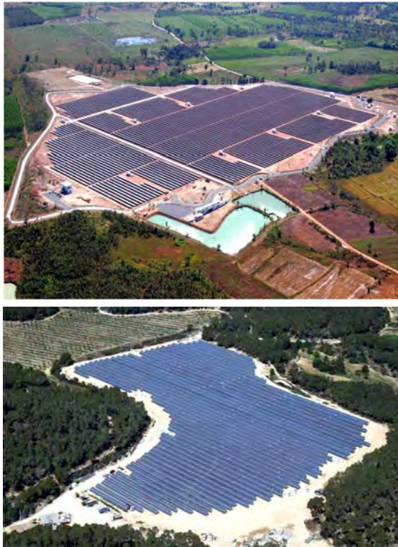
โรงงานผลิตกระแสไฟฟ้าจากเซลล์แสงอาทิตย์
