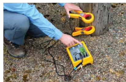
การตรวจวัดระบบกราวด์ (Earth Ground Resistance)
