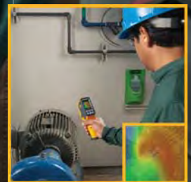
งานซ่อมบำรุงในโรงงาน
