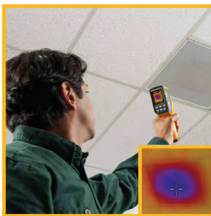
งานปรับอากาศ HVAC/R
