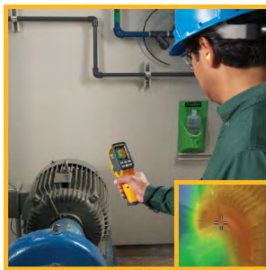
งานซ่อมบำรุงโรงงาน
