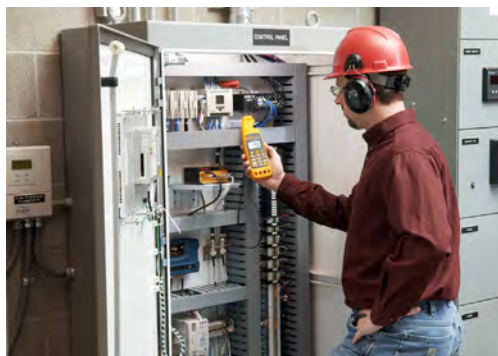
วัดกระแสลูป 4-20 mA ได้โดยไม่ต้องตัดวงจร ช่วยประหยัดเวลาทำงานและลดต้นทุนลูปเปล่า
