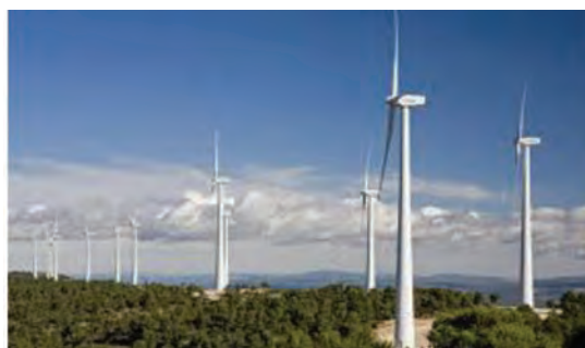
สถานีผลิตไฟฟ้าจากพลังงานลม
