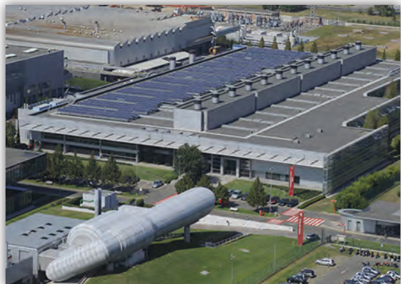
สถานีไฟฟ้าผลิตกระแสไฟฟ้าจากหลังบ้านแสงอาทิตย์ ติดตั้งบนหลังคาอาคารพาณิชย์
