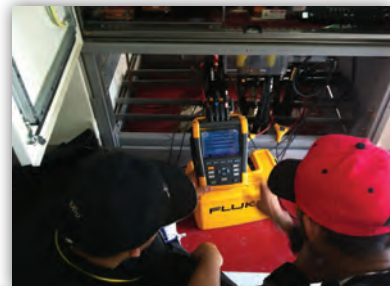
Fluke 435-II เครื่องวัดประสิทธิภาพและคุณภาพทางไฟฟ้าที่ค่ากลับไม่เกิน 6 MW
