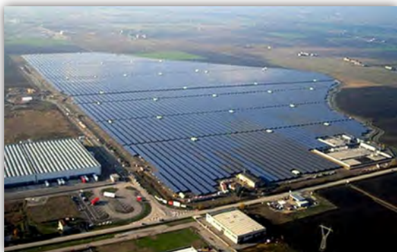
สถานีไฟฟ้าผลิตกระแสไฟฟ้าจากหลังบ้านแสงอาทิตย์
