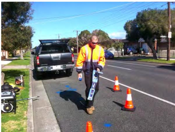
เมื่อมีความจำเป็นในการเปิดหน้าพื้นดินเพื่อการปรับปรุงหรือก่อสร้างใดๆ ตลอดจนการซ่อมบำรุงต่างๆ ผู้รับเหมาจำเป็นที่จะต้องดำเนินการสำรวจพื้นที่บริเวณใต้ดินก่อนเริ่มทำงานว่ามีแนวท่อหรือแนวสายไฟ, แนวสายระบบโทรคมนาคมอยู่ในบริเวณที่ต้องการขุดหรือไม่ เพื่อหลีกเลี่ยงความเสียหายที่อาจเกิดขึ้น หรือหากจุดที่ต้องการเปิดหน้างานได้อย่างถูกต้องแม่นยำ
