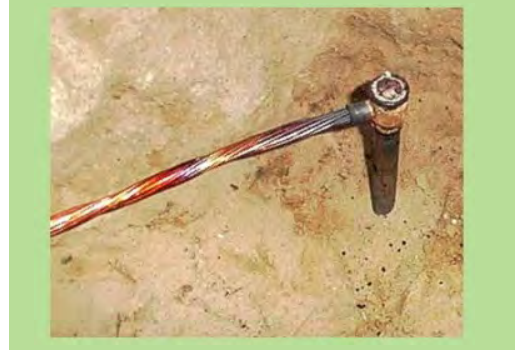
ตัวอย่าง การต่อหลักดินด้วยชุดเบ้าหลอมหลักดิน
