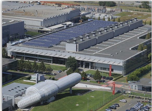
สถานีไฟฟ้าผลิตกระแสไฟฟ้าจากพลังงาน แสงอาทิตย์ ติดตั้งบนหลังคาอาคารพาณิชย์
