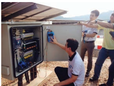
การวัดระบบกราวด์ที่แผงโซลาร์เซลล์
