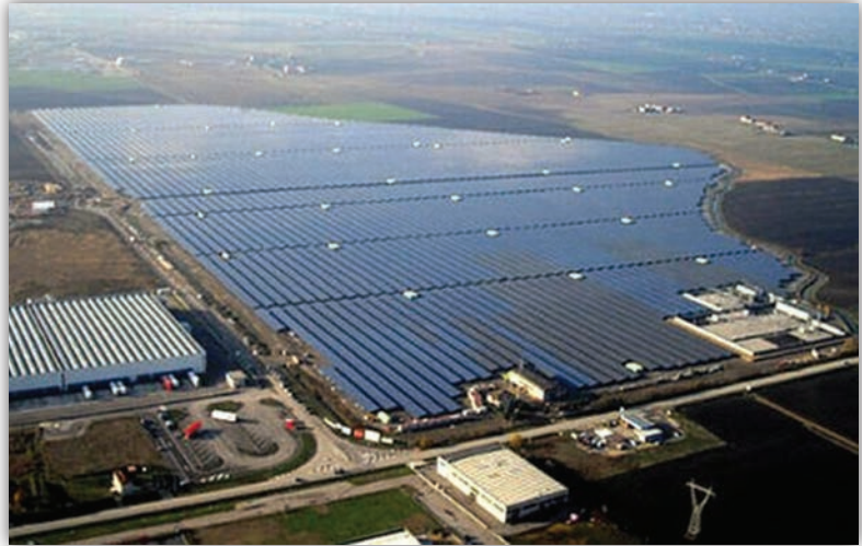
สถานีไฟฟ้าผลิตกระแสไฟฟ้าจากพลังงานแสงอาทิตย์
