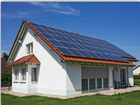
สถานีไฟฟ้าผลิตกระแสไฟฟ้าจากพลังงาน แสงอาทิตย์ ติดตั้งบนหลังคาบ้าน
