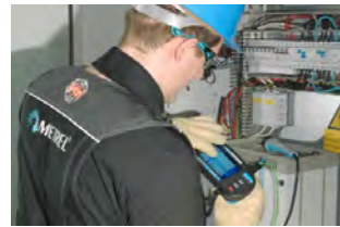
การตรวจสอบระบบไฟฟ้าในตู้ควบคุม
