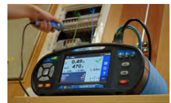
การทดสอบฉนวนที่ตู้ควบคุม
