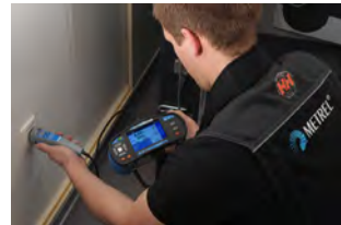
การทดสอบระบบไฟฟ้าที่เต้ารับแบบ 1 เฟส
