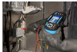
การทดสอบฉนวนของตัวตัดป้องกันลัดวงจร
