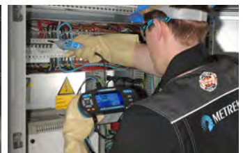
วัดความต่อเนื่องด้วยกระแส 200mA
