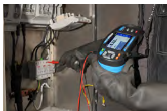
วัดอนวนไฟฟ้าสูงสุด 1000V/999MΩ
