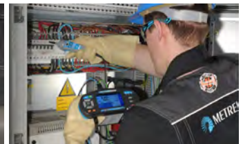
วัดความต่อเนื่องด้วยกระแส 200mA
