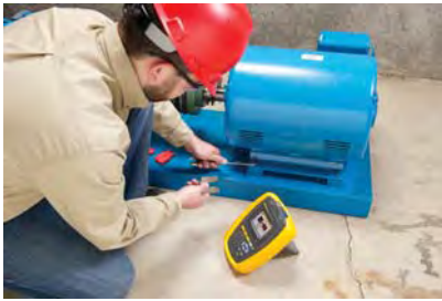
การปรับตั้งฐานยึดเครื่องจักรด้วยเข็ม ตามระยะที่ระบุบนหน้าจอ
