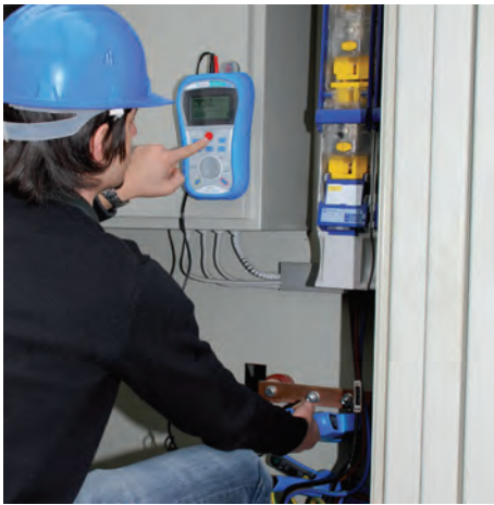
ทดสอบความต้านทานระบบกราวด์ของอุปกรณ์ลงดินหลัก
