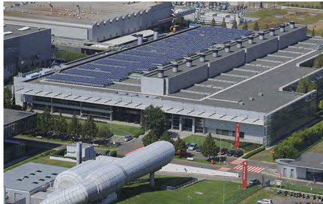
สถานีไฟฟ้าผลิตกระแสไฟฟ้าจากพลังงานแสงอาทิตย์ ติดตั้งบนหลังคาอาคารพาณิชย์
