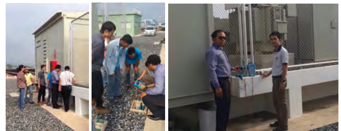
การวัดระบบกราวด์ที่สถานีไฟฟ้า
