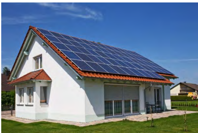
สถานีไฟฟ้าผลิตกระแสไฟฟ้าจากพลังงานแสงอาทิตย์ ติดตั้งบนหลังคาบ้าน
