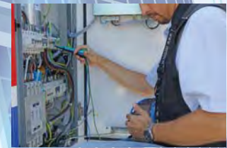
วัดความถี่เนื่องด้วยกระแส 200mA
