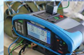
ตรวจวัดกระแสรั่วไหล ทดสอบการทำงานของเครื่องตัดไฟรั่ว
