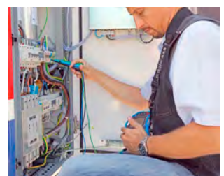
วัดความต่อเนื่องด้วยกระแส 200mA
