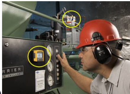
(3) แบบถอดแยกภาคแสดงกับภาควัดออกจากกันเพื่อดูผลการวัดจากระยะไกลแบบไร้สายได้
